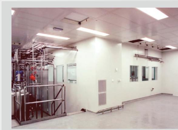
Сначала на поверхность накладывается основное цинковое покрытие. Затем наносится краска PVDF (стандартно RAL 9010) и покрывается лаком. Максимально возможная ширина перегородочной панели
